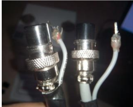
Gambar 1.6 Kabel dan konektor penghubung
