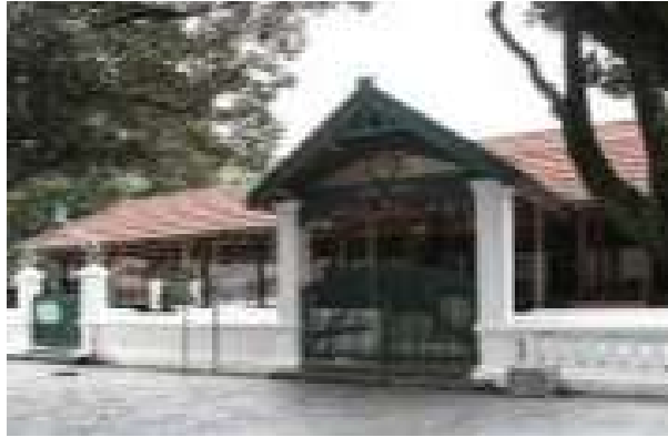
Gb. Eksterior Masjid Gedhe Mataram Kotagedhe Sumber : Dokumentasi Penulis, 2024
