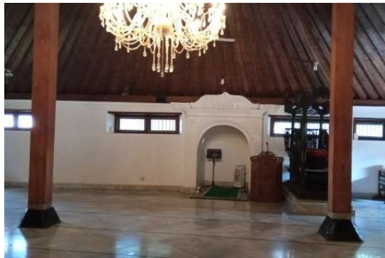
Gb. Interior Masjid Dokumentasi Penulis, 2024
