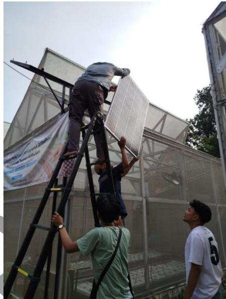
Gambar 9. Pemasangan panel surya
